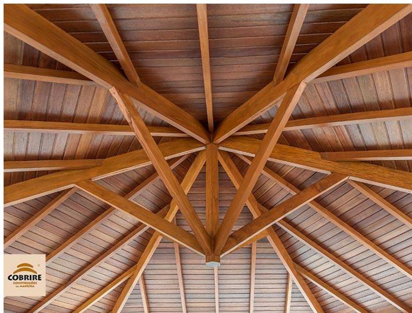
Figura 2 - Detalhe da sustentação central da cobertura dos caramanchões Fonte: https://cobrire.com.br/quiosque-cobertura-de-telha-portfolio/
